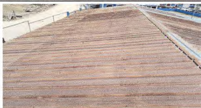
Foto 1: Sustitución de lámina, por lámina troquelada aluzinc calibre 26 en aulas + Sustitución de capote de lámina para lámina troquelada + Sustitución de elementos de fijación
