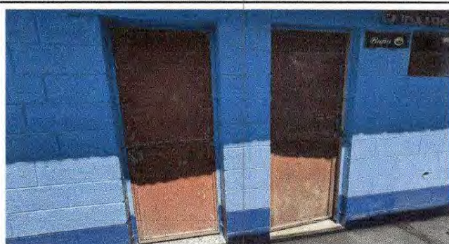
Foto 4: Sustitución de puerta en servicios sanitarios
