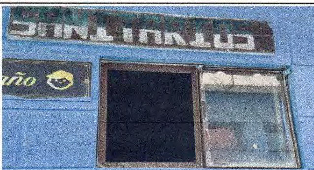
Foto 5: Mantenimiento a estructura de metal de ventana +
