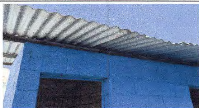
Foto 2: Sustitución de estructura de soporte de madera, por metal en servicios sanitarios.
