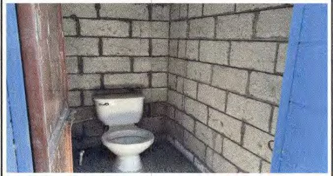
Foto 8: Sustitución de azulejo
