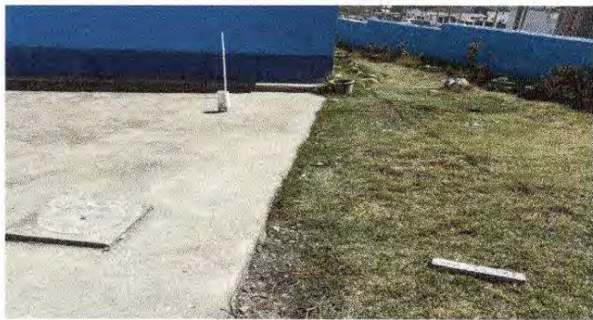
Foto 9: Reparación de planchas de concreto de patio
