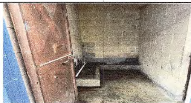
Foto 6: Pintura en muros interiores
