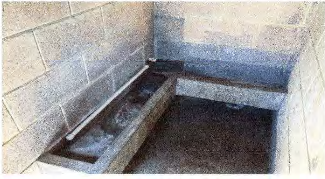
Foto 7: Sustitución de mingitorio
